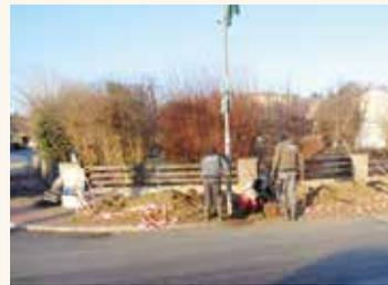
Die Ortsbeleuchtung in Willersdorf war bis jetzt eine Einheit bzw. ein Schaltkreis. Den Nachteil hatten wir des Öfteren gemerkt, wenn an einer Lampe irgendwo ein Fehler aufgetreten ist, war der ganze Ort dunkel. Um diesen Umstand zu beheben wurde ein Viertelschaltssystem eingebaut. Im Falle eines Fehlers ist nur mehr das eine Viertel finster. Die anderen Teile sind weiter erleuchtet. Durch die Eingrenzung können die Fehler auch schneller behoben werden.
