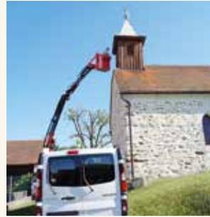
Die Holzverkleidung im Turmbereich wurde saniert und mit einem neuen Holzschutz ausgestattet. Ebenso wurde bei der Eingangstür das Holz mit einem neuen Anstrich versehen. Am Dach mussten einige gebrochene Ziegel ausgetauscht werden.
